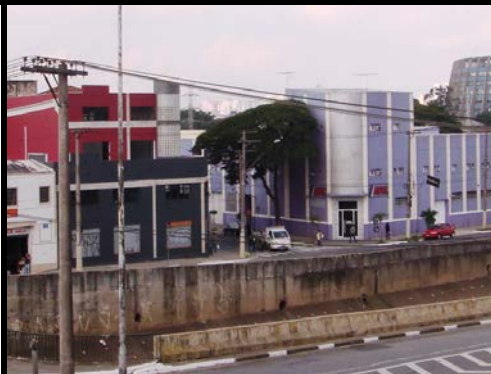
Construção-Hotel e Fabrica - Av Estado-Armênia
