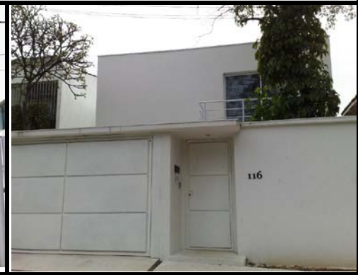
Construção-Residência-Rua Tefé- Sumaré
