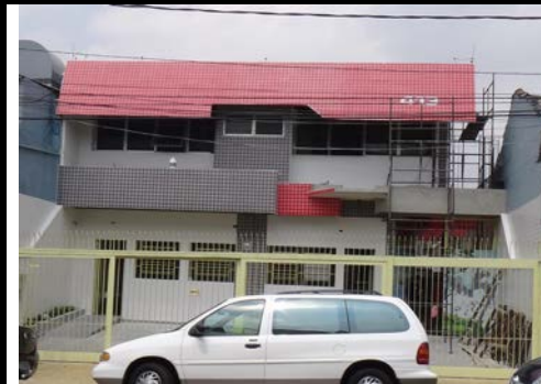
Construção-Creche Cambuci-Fund. Reviver
