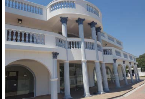
Em obras- Asilo-Fundação Reviver-Tremembé
