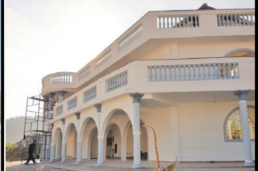
Em obras- Asilo-Fundação Reviver-Tremembé
