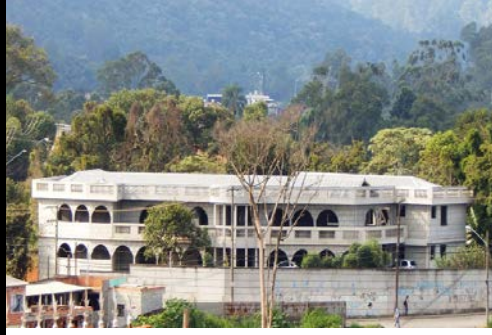
Em obras- Asilo-Fundação Reviver-Tremembé
