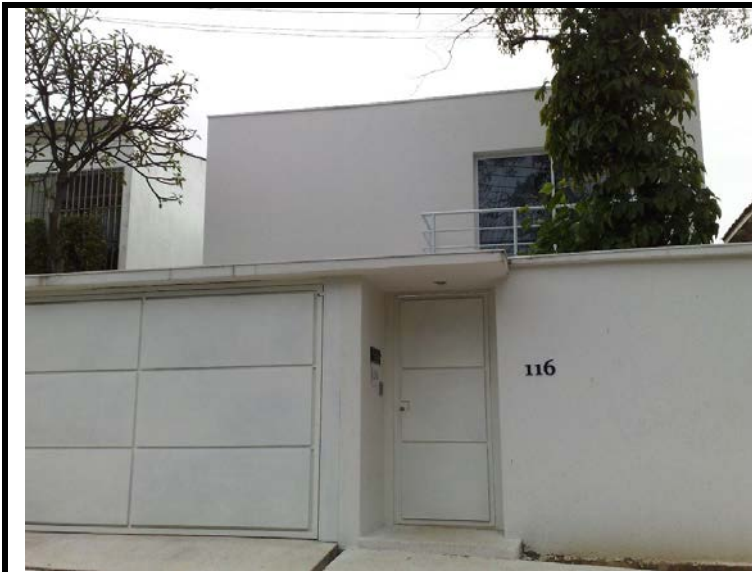
Construção-Residência: Rua Tefé - Sumaré
