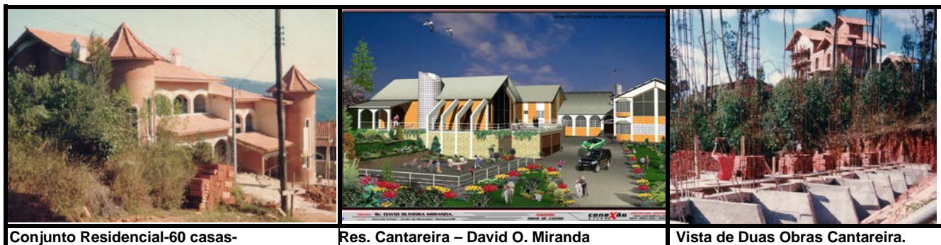
Conjunto Residencial-60 casas-
