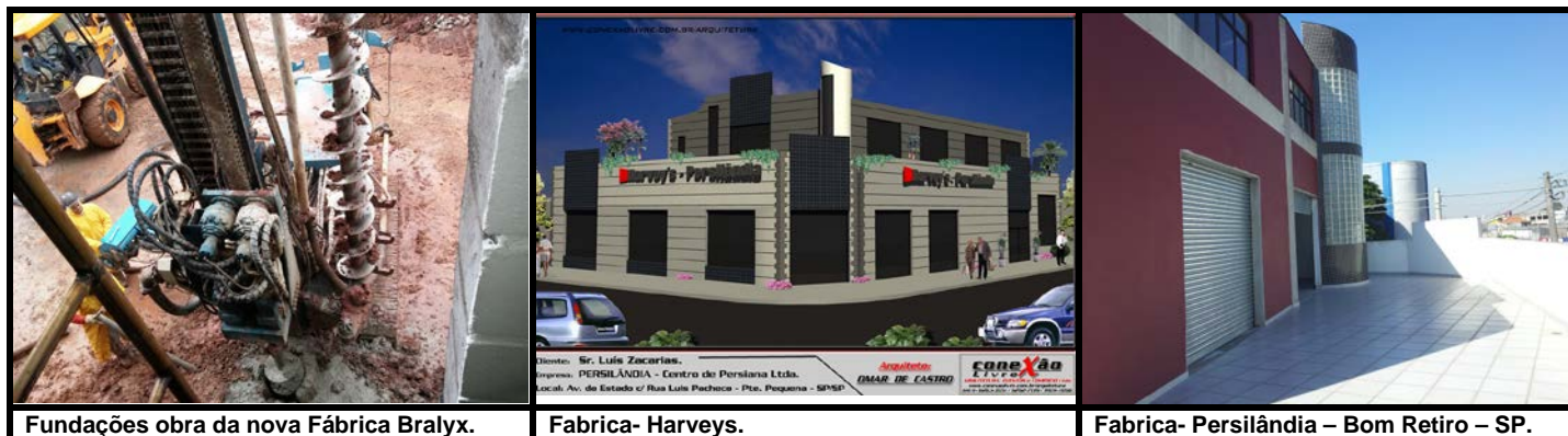
Fundações obra da nova Fábrica Bralyx.
